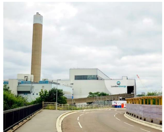
Abbildung 1: Müllverbrennungs-KWK-Anlage in London, UK.
