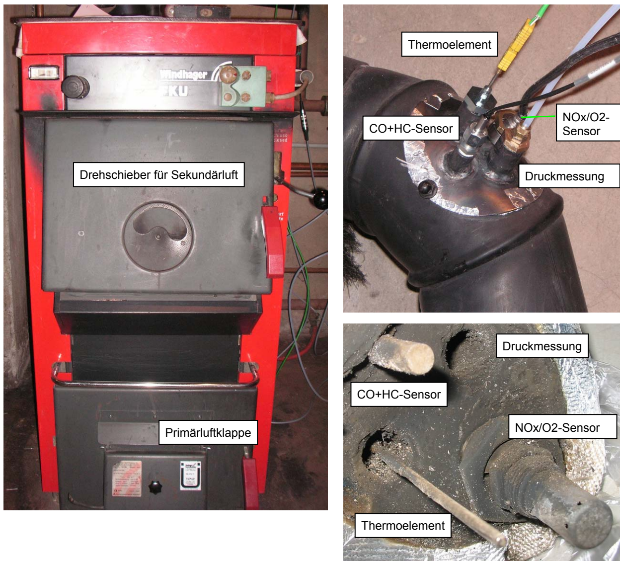
Bild 3-4 Messbox 3 eingesetzt am Stückholzkessel und Einbausituation der Sensoren im Abgasrohr sowie Sondenverschmutzung am Ende des Feldtests
