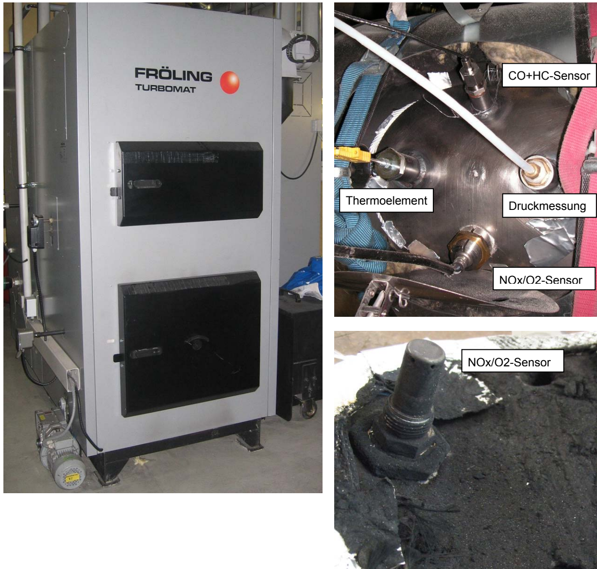
Bild 3-1 Messbox 1 eingesetzt am Pelletkessel und Einbausituation der Sensoren im Abgasrohr sowie Sondenverschmutzung am Ende des Feldtests
