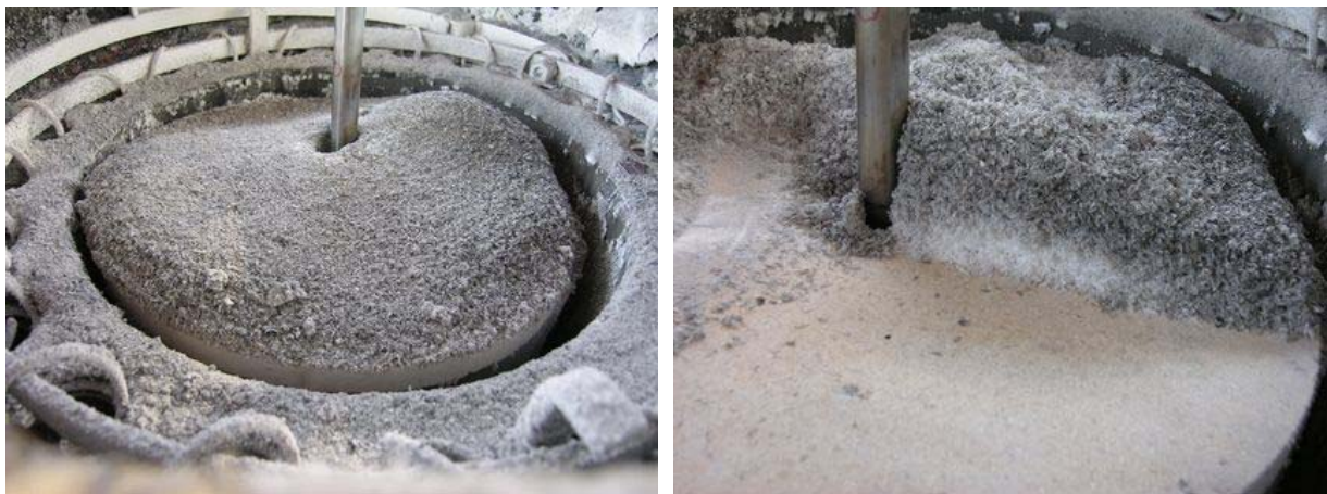
Abbildung 12: Staubablagerungen auf der Abdeckung der Ausbrandglocke
