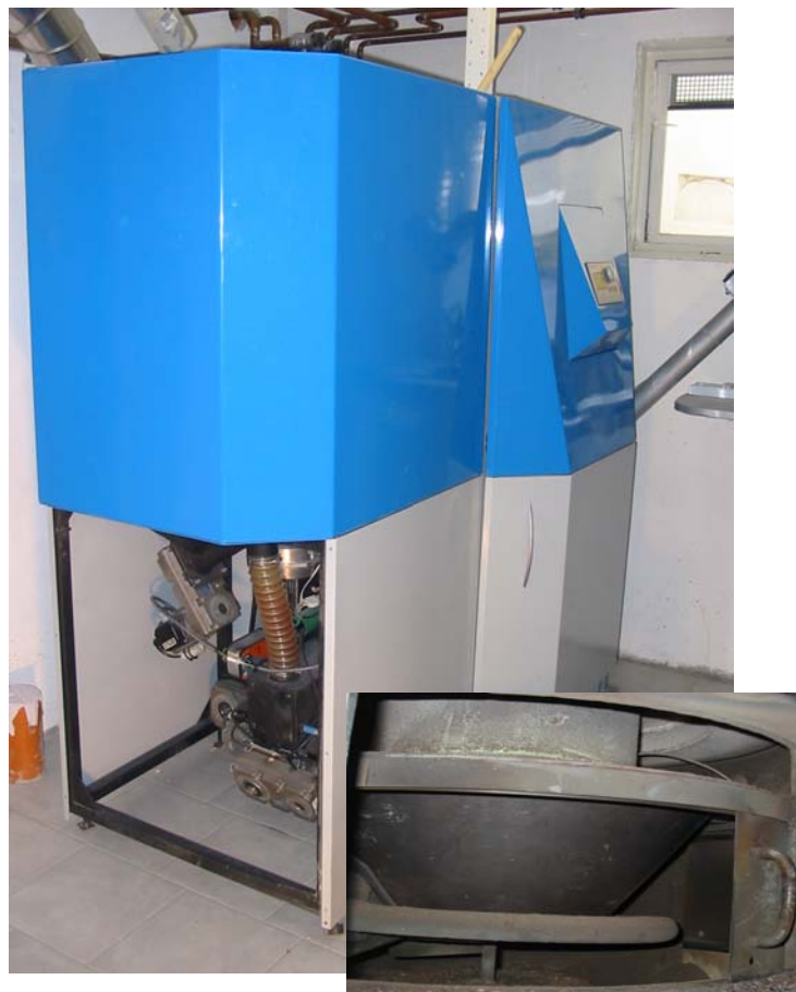
Bild 4.1: Schnittbild vom untersuchten Agroflam-Heizkessel Agro 40 (oben) und Einbausituation bei den Messungen mit Ausschnitt der Brennkammer
