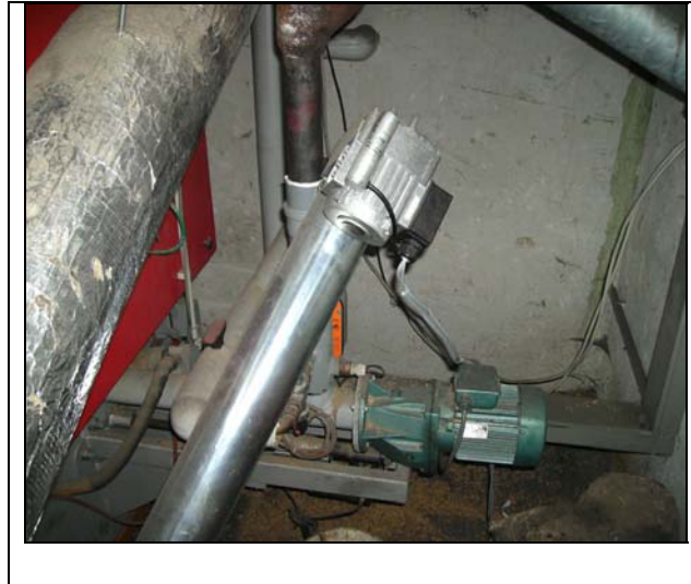
Bild 5.10: Kalkdosierung im Fallrohr zwischen Steigschnecke und Stokerschnecke beim Heizkessel Ökothem
