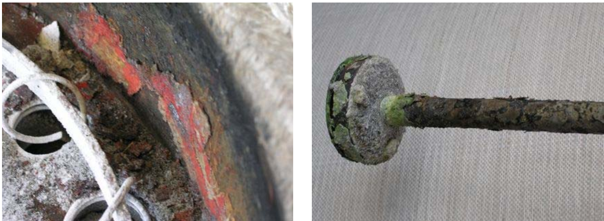
Abbildung 15: Korrosionserscheinungen am Wärmetauscher (links) und an der Verbrennungsluftlanze (rechts)
