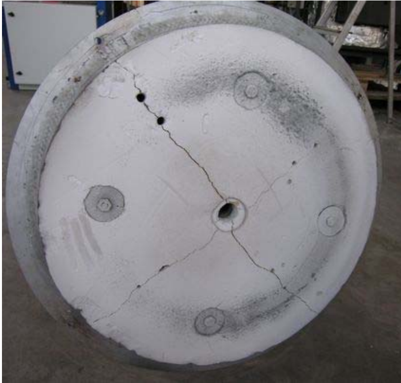
Abbildung 13: Deckel der Feuerung mit Staubablagerungen
