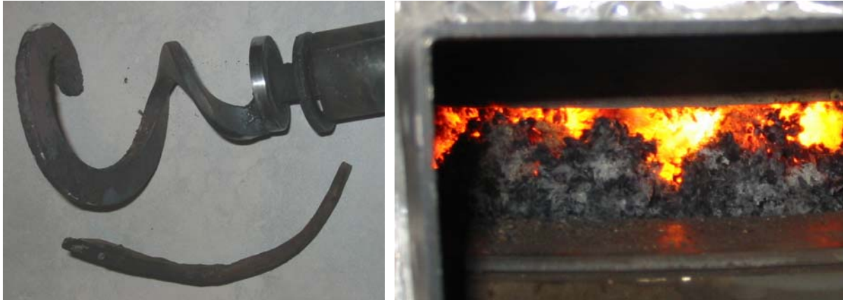
Bild 4.2 Rührhacken mit abgebrochenem Metallstück (links) und überfüllte Brennerschale (rechts) bei Heizkessel Agro 40
