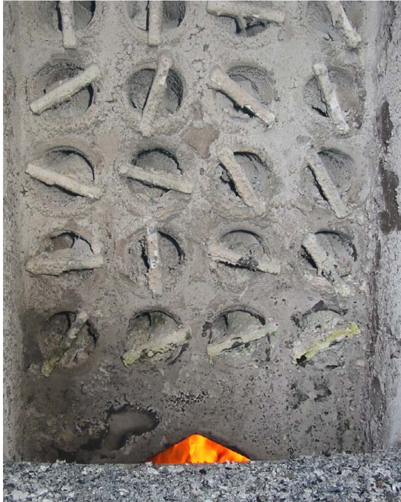
Bild 4.6: Wärmetauscherverschmutzung des Passat-Heizkessel Compact C8 nach einem mehrstündigen Betrieb mit Reinigungspellets
