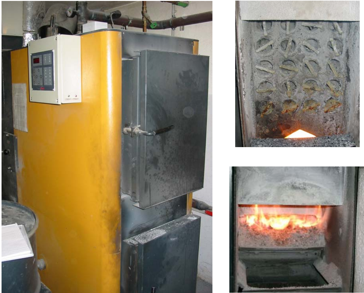
Bild 4.5: Ansicht des Passat-Heizkessel Compact C8 mit Wärmetauscher und Feuerraum
