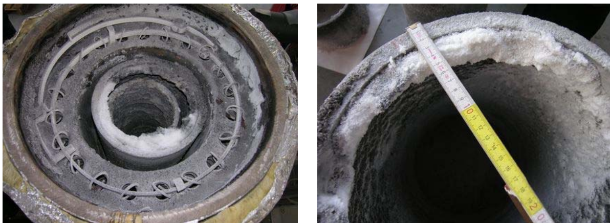
Abbildung 14: Staubablagerungen in den Umlenkammern
