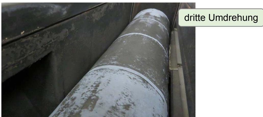
**Abbildung 5.14** Abreinigung mittels Absaugung - Darstellung der Reinigungswirkung bei einer bis drei Umdrehungen der Filterpatrone im kalten Zustand
