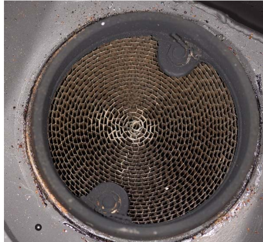
Abbildung 2.53 Katalysatoren der Fa. Clariant International LTD: Einbausituation unmittelbar vor dem Abgasstutzen des Kaminofens Hark 44 GT ECOplus
