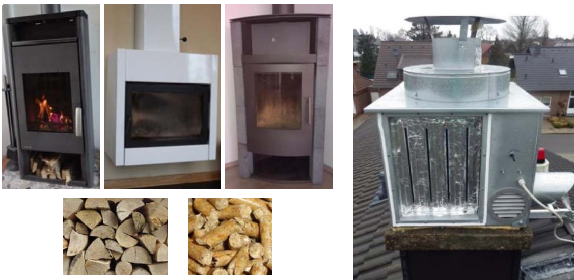
Abbildung 2.31 Entwicklung der RWTH Aachen: Feinstaubabscheidung mit Tiefenfilter (Wohter und Quicker, 2016)
